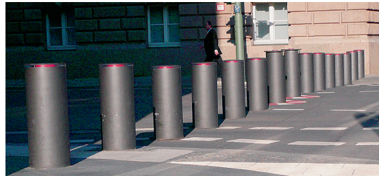
Abbildung 2: Terror-Poller, oben versenkbare Poller, unten Jersey-Barrieren und Beton-Poller
